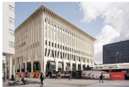
Kulturzentrum Amare Größtes Kulturgebäude der Niederlande
